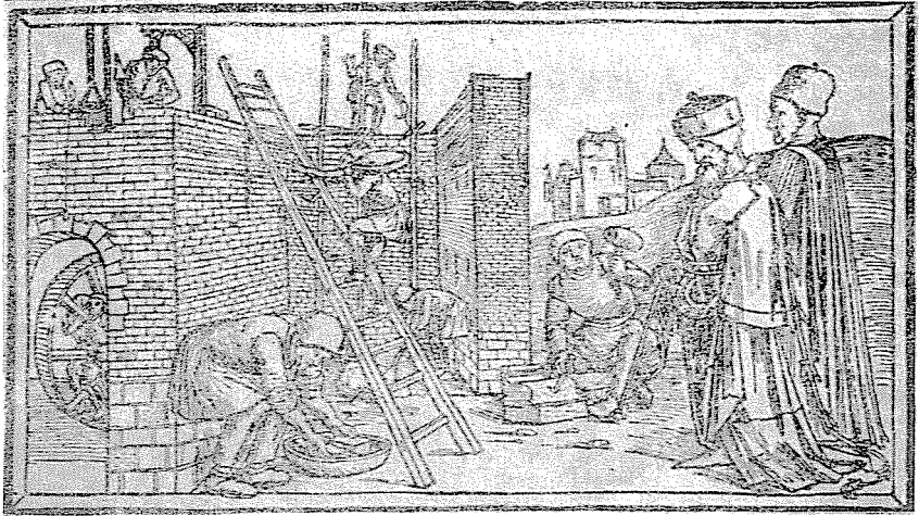
Bild 27. Besuch des Bauherrn am Bau
