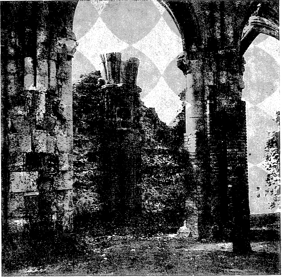
Bild. 3. Ziegeluntermauerung und -ergänzung im südlichen Seitenschiff
