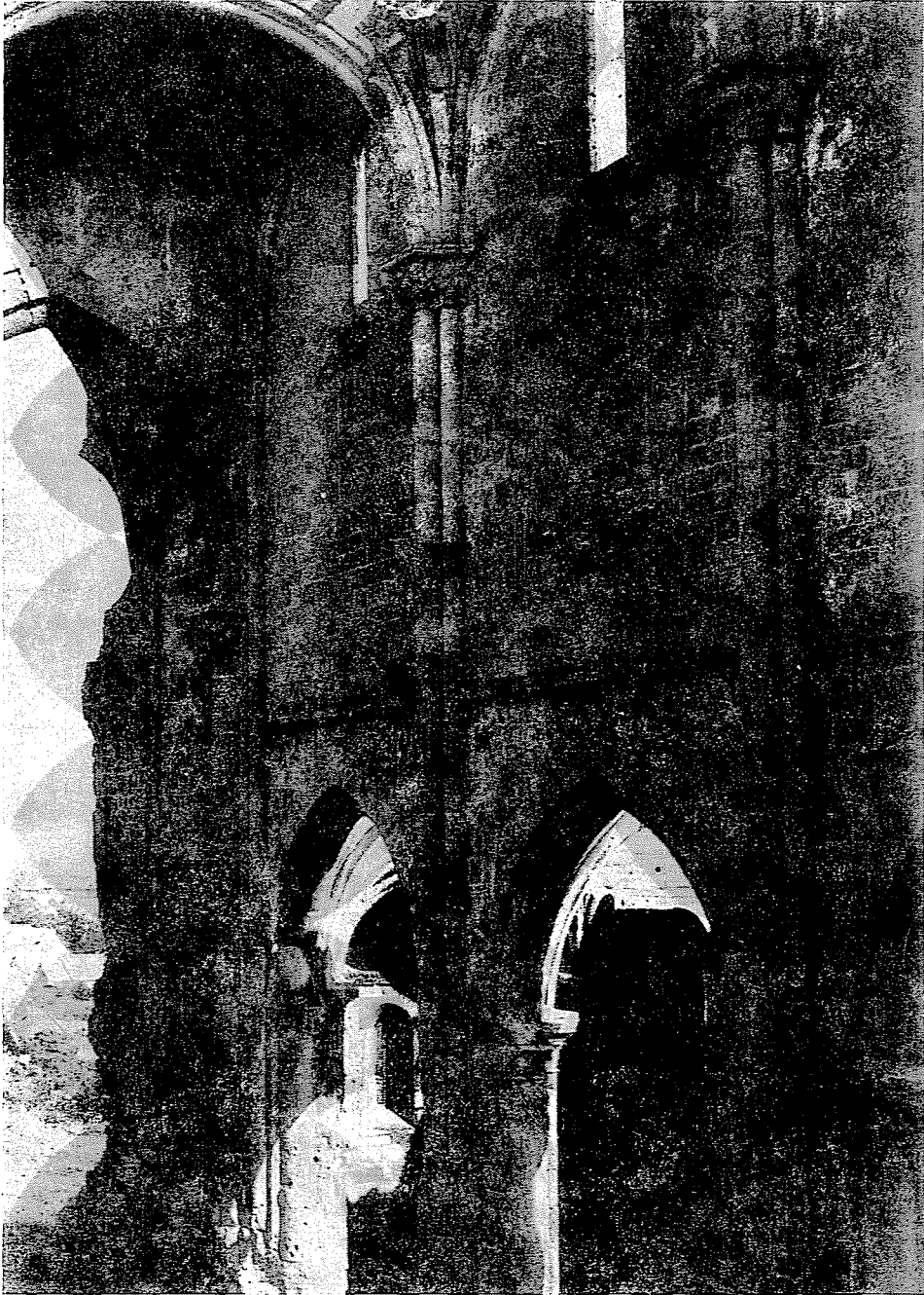
Bild. 6b. Gewölbejoch des Hauptschiffes nach der von G. Lux durchgeführten Betonergänzung
