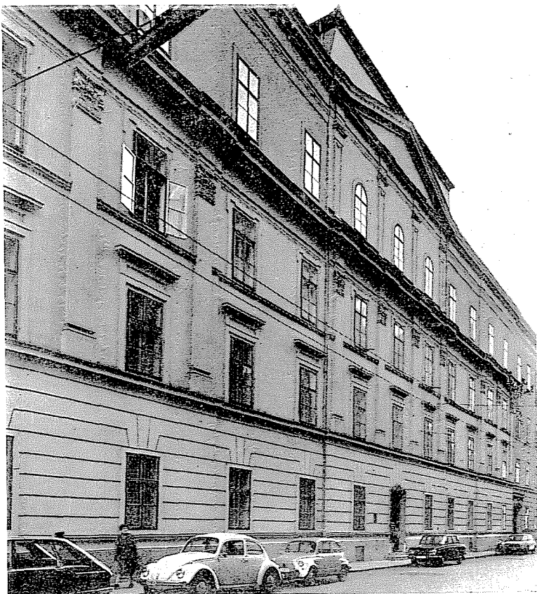
Bild 5. Oberflächenschutz mit unsichtbarem, luftdurchlässigem Schutzanstrich (Barra Sil) bei der Wiederherstellung der Fassade des Gebäudes des Priesterseminars Budapest V. Eötvös-Straße 5–7. (Anstatt der im Krieg größtenteils zugrunde gegangenen eklektischen Fassade wurde die ursprüngliche Barockfassade aus dem 19. Jh. rekonstruiert.) Der Deckenanstrich der verschiedenen alten Teile des Verputzes bedeutete eine schwierige Aufgabe
