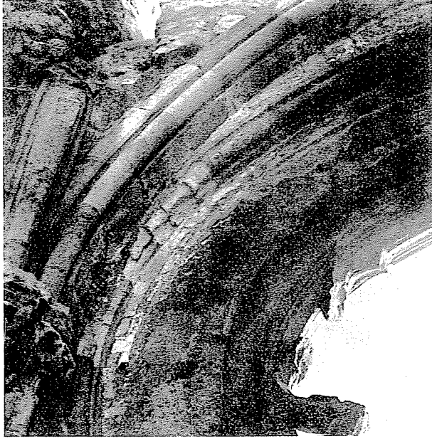
Abb. 9. Das (zum Teil vermauerte) Profil der großen Rosette der Fassade aus der I. Periode und die spätere verkleinerte Form
