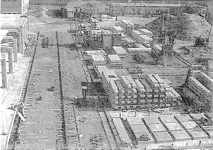
Fig. 1. Préfabrication sur chantier des éléments linéaires
