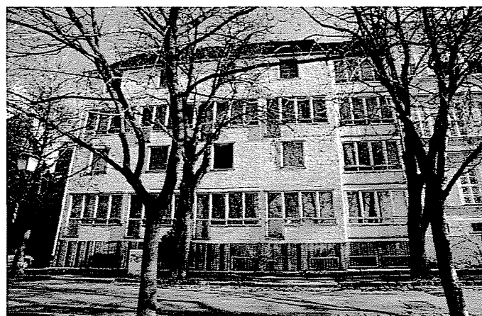
Fig. 4. Apartment house. Tóth Árpád sétány 27.
