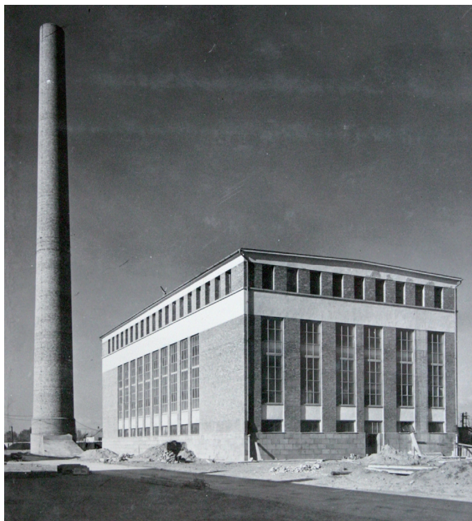
Fig. 23. KBoiler house, Debrecen ball-bearing factory. Designers: István Füzér, István Hermány and co. 1952-1953. (By kind permission of Foundation for Modern Industrial Architecture – IPARTERV Photo Archive / A (Modern) (Ipári) Építészeti Alapítvány – IPARTERV Fotóarchívum)
