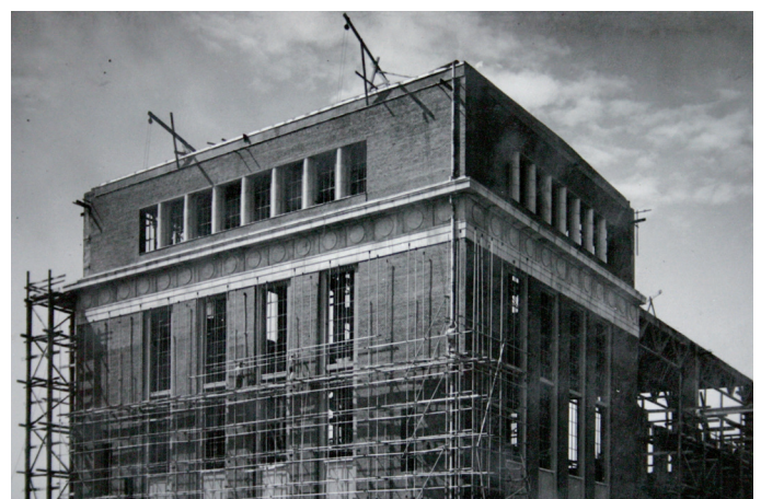
Fig. 22. Power station, Csepel paper factory. (By kind permission of Foundation for Modern Industrial Architecture – IPARTERV Photo Archive / A (Modern) (Ipari) Építészeti Alapítvány – IPARTERV Fotóarchívum)
