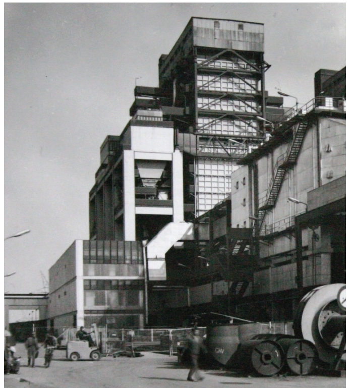
Fig. 27. Gagarin power station in Gyöngyösvisonta. (By kind permission of Foundation for Modern Industrial Architecture – IPARTERV Photo Archive / A (Modern) (Ipari) Építészeti Alapítvány – IPARTERV Fotóarchívum)
