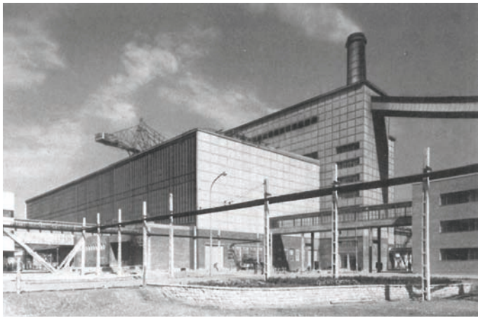
Fig. 14. Oroszlány power station. Designers: László Berezky, József Pomogáts, Dénes Domaniczky, Vilmos Péry, Miklós Ugrai, István Ivits. 1959-1960. (By kind permission of Foundation for Modern Industrial Architecture – IPARTERV Photo Archive / A (Modern) (Ipari) Építészeti Alapítvány – IPARTERV Fotóarchívum)
