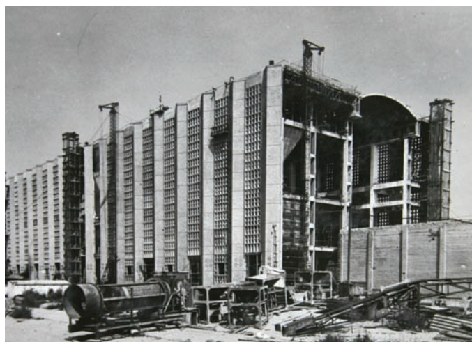
Fig. 3. Pécsújhely power station. Structure. (By kind permission of Foundation for Modern Industrial Architecture – IPARTERV Photo Archive / A (Modern) (Ipari) Építészettér Alapítvány – IPARTERV Fotóarchívum)
