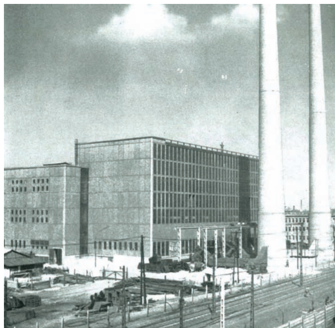
Fig. 11. Kőbánya power station. Designers: Endre Resatkó, Frigyes Völgyes, Sándor Szűcs. 1958-1960. [33, p. 223.]
