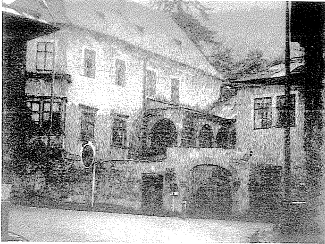
Abb. 3. Die erste Gebäude der chemische Lehrstuhl in Selmecbánya (1863–1895)
