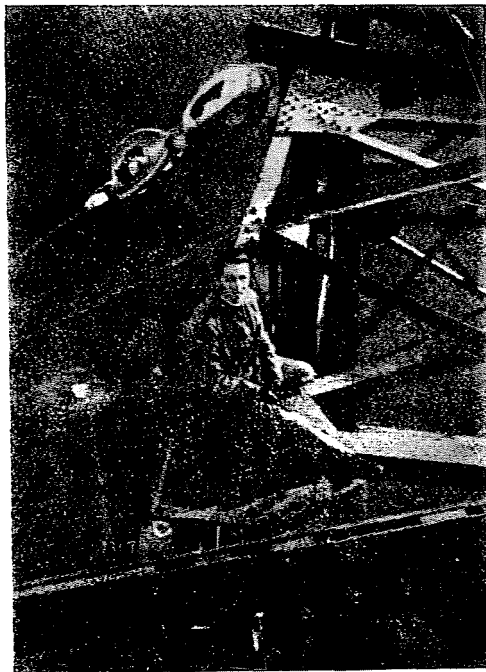
Abb. 10. Doppelter Seilisolator
