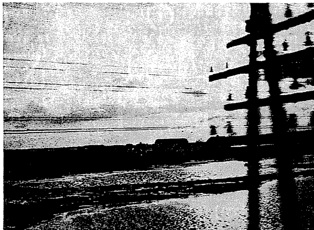
Photo 1. Notwendigkeit der Flachlandentwässerung (im Donau —Theiß-Gebiet im Jahre 1941 gegen den 15. 5.)
